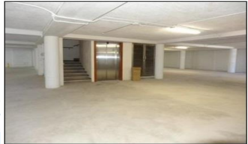
Vista de estacionamiento en sótano.
